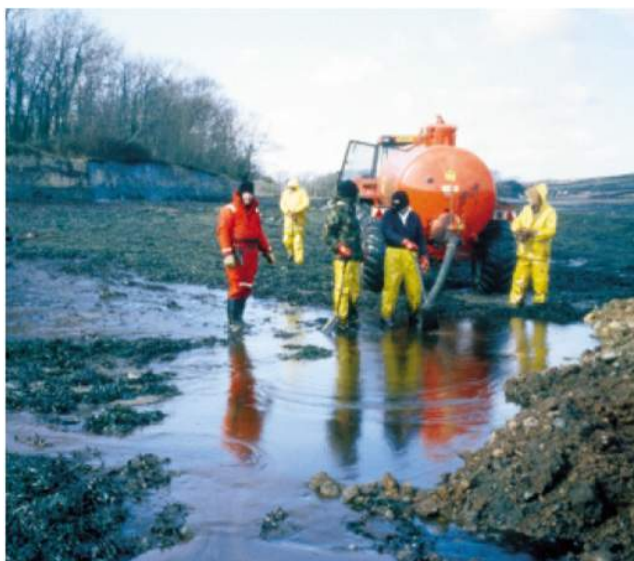
شکل ۸۴: استفاده از سیستم پمپ مکشی جهت جمع آوری نفت از ساحل (۲)
