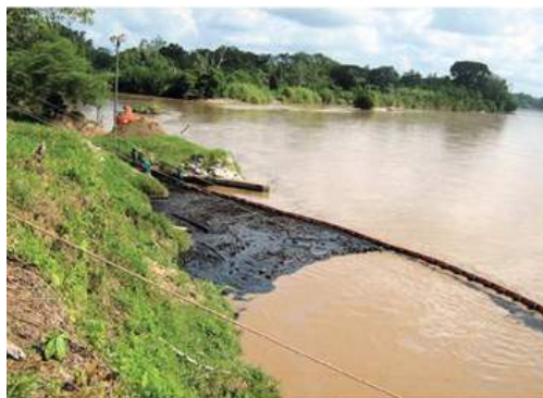
شکل ۳۴: ممانعت از ورود مواد نفتی به رودخانه با استفاده از بوم (۲)
