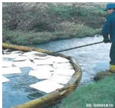
شکل ۹: گستراندن ترکیبات جاذب بر سطح آب های جاری جهت جلوگیری از آلودگی آب های سطحی
