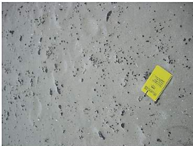
شکل ۱۱: گلوله های قیری بسیار ریز در بستر ساحل (۲)
