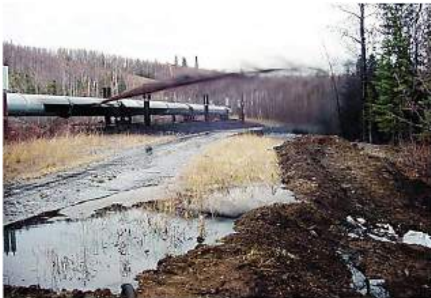
شکل ۱۵: شکستگی لوله انتقال نفت بعلت فرسودگی در آلاسکا (۲)
